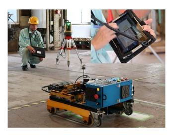
自動墨出しロボットシステムによる作業(右上は作業指示用タブレット端末)
